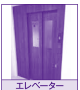
エレベーター
