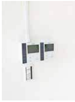
3F エアコンリモコン
