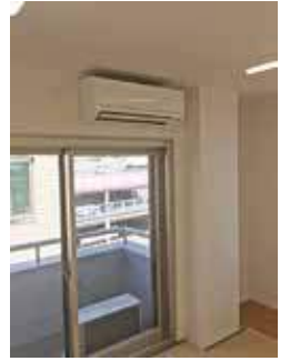
3F 和室エアコン
