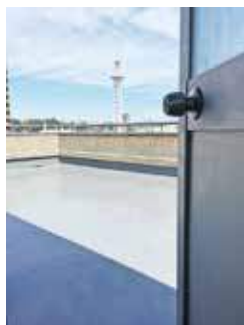
4F 屋上入口
