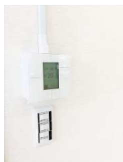
2F エアコンリモコン
