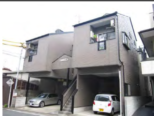
ポラリス箱崎東Ⅰ（2月竣工/6戸：福岡市東区）
