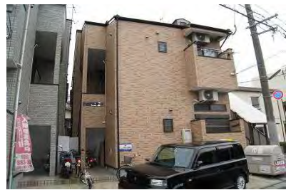
サンピース井尻 (12月竣工/6戸：福岡市南区)
