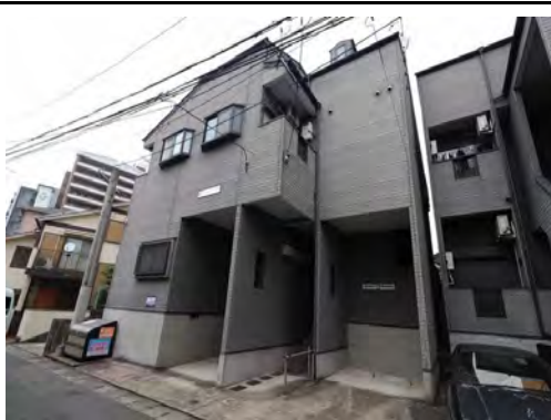
クリスタルハーモニー別府 (3月竣工/5戸: 福岡市城南区)
