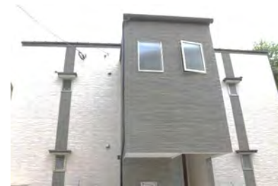
ハビネス二日市 (2月竣工/4戸：筑紫野市)
