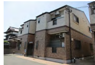
ポラリス周船寺Ⅳ (8月竣工/8戸：福岡市西区)
