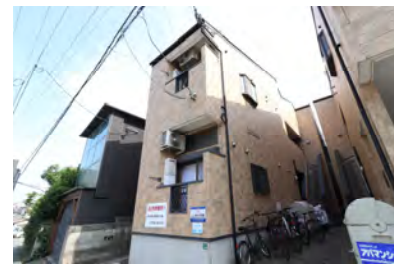
RAKUコーポ田島 (6月竣工/8戸：福岡市城南区)
