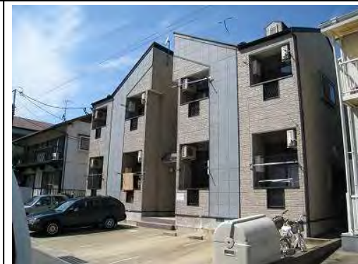
ポラリスマリーナ（12月竣工/8戸：福岡市西区）
