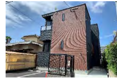
クレ (8月竣工/6戸：糸島市)
