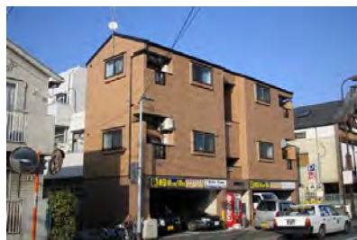
GOLDWING西新南 (3月竣工/4戸：福岡市早良区)
