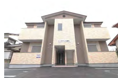
ポラリス城内 (3月竣工/4戸：唐津市)
