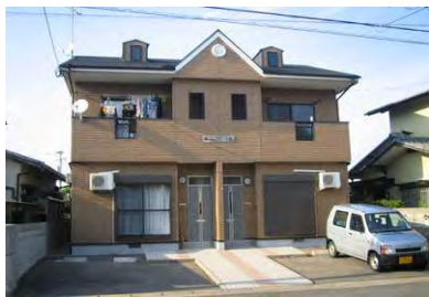
フレグランス田隈 (1月竣工/2戸：福岡市早良区)
