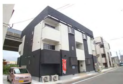
W-000 (3月竣工/8戸：福岡市西区)
