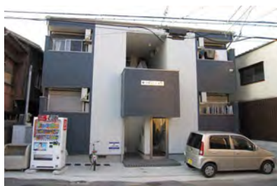
パサージュ地行 (10月竣工/4戸：福岡市中央区)
