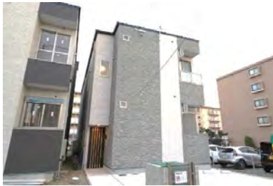
シーエスコート (10月竣工/6戸：福岡市早良区)
