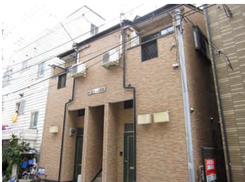
ポラリス住吉 (12月竣工/4戸：福岡市博多区)
