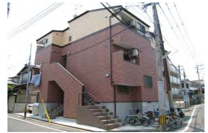
ボラリス西新 (12月竣工/8戸：福岡市早良区)
