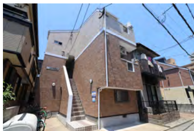
DCT大橋 (6月竣工/6戸：福岡市南区)
