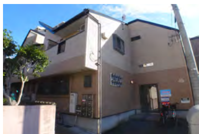
ステラポラリス愛宕 (3月竣工/9戸：福岡市西区)
