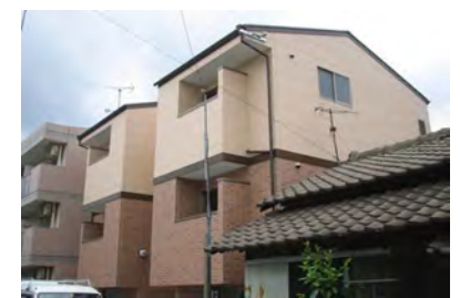
パサージュ周船寺 (8月竣工/4戸：福岡市西区)
