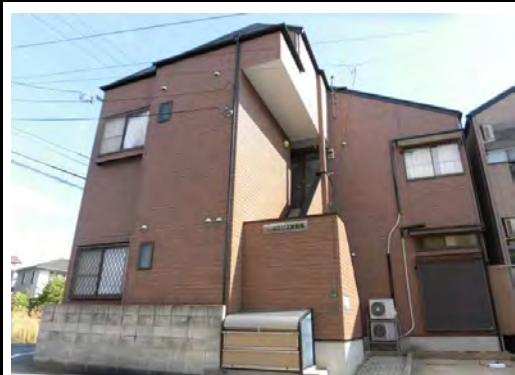
ポラリス室見南（9月竣工/6戸：福岡市早良区）
