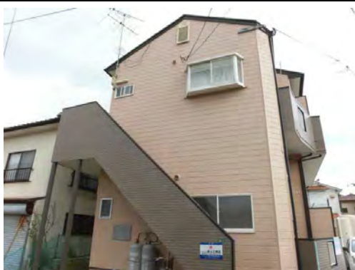
ベルハウス (7月竣工/6戸：福岡市西区)
