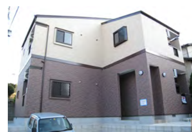
キャメロット前原駅南（12月竣工/4戸：糸島市）
