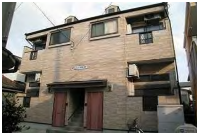
エレガントDOMESIDE (3月竣工/4戸：福岡市中央区)
