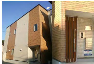
フェリシアガーデン大橋 (8月竣工/6戸：福岡市南区)
