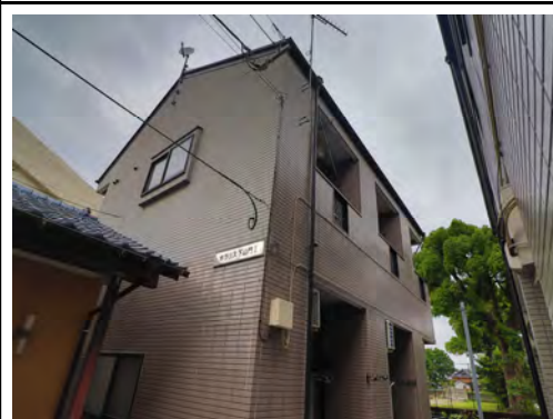
ポラリス下山門Ⅰ（3月竣工/6戸：福岡市西区）
