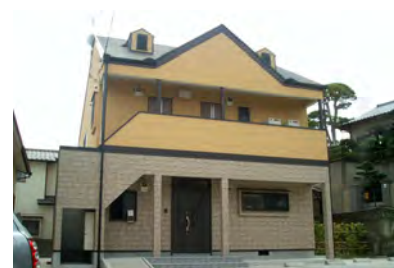
ポラリス橋本西 (4月竣工/2戸：福岡市西区)
