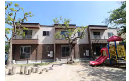
Flurish桜花（5月竣工/3戸：福岡市城南区）
