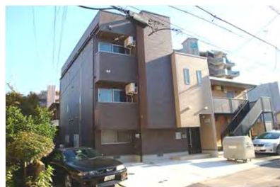
西新パークサイド (9月竣工/4戸：福岡市中央区)
