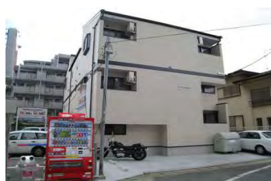
セレス室見 (7月竣工/9戸：福岡市西区)
