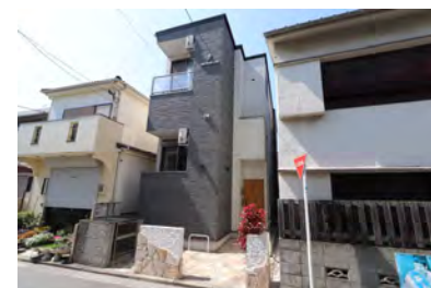
POLARIS Crane JIGYO (5月竣工/4戸：福岡市中央区)
