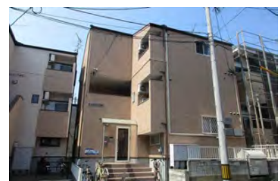
ボーマノワール姪浜 (3月竣工/6戸：福岡市西区)
