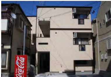
ティエラ大橋 (1月竣工/8戸：福岡市南区)
