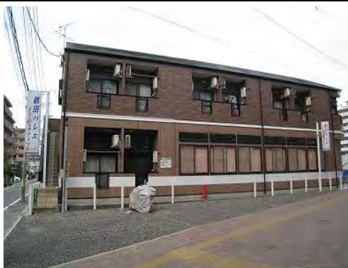
ポラリス姪浜 (7月竣工/10戸：福岡市西区)
