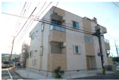
アイディールモア博多 (10月竣工/8戸：福岡市博多区)
