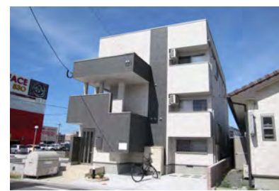
ポラリス九研駅前 (3月竣工/6戸：福岡市西区)
