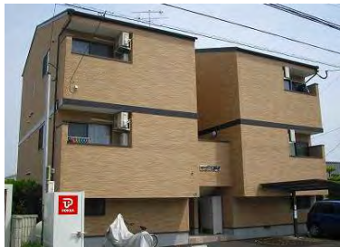
ペガダ周船寺 (4月竣工/8戸：福岡市西区)
