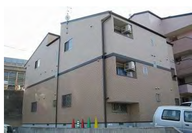
ボラリス西の丘（11月竣工/6戸：福岡市西区）
