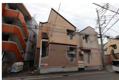
ドリア・イヌール (8月竣工/6戸：福岡市早良区)
