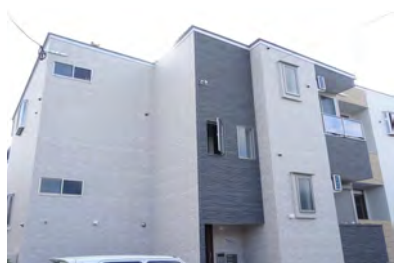
ルナーリア竹下 (8月竣工/6戸：福岡市南区)
