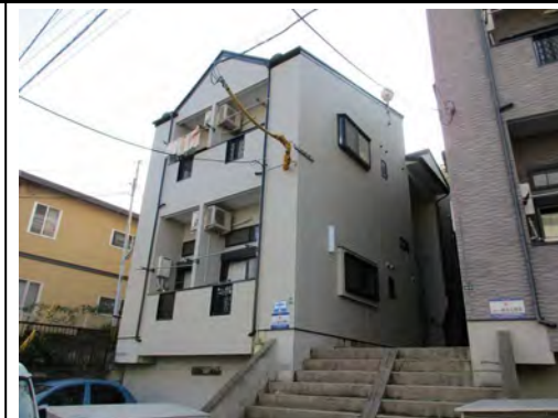
ポラリス藤崎Ⅱ（10月竣工/8戸：福岡市早良区）
