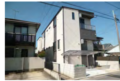
エイトリー箱崎 (10月竣工/6戸：福岡市東区)
