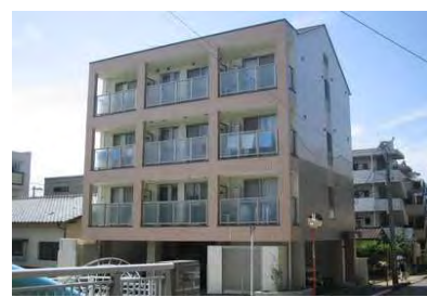
ピコロ姪浜 (4月竣工/9戸：福岡市西区)
