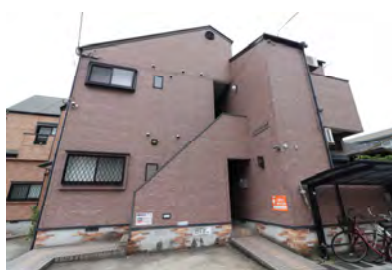
フォントーン西新 (9月竣工/8戸：福岡市早良区)
