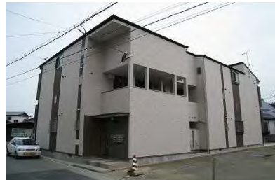
クリスタルK九大南3 (2月竣工/8戸：福岡市西区)
