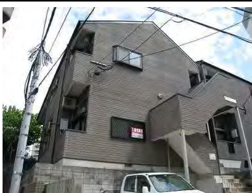
ポラリス高宮Ⅰ（7月竣工/10戸：福岡市南区）
