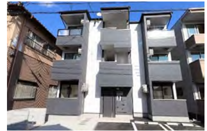
アネシス博多 (11月竣工/6戸：福岡市南区)
