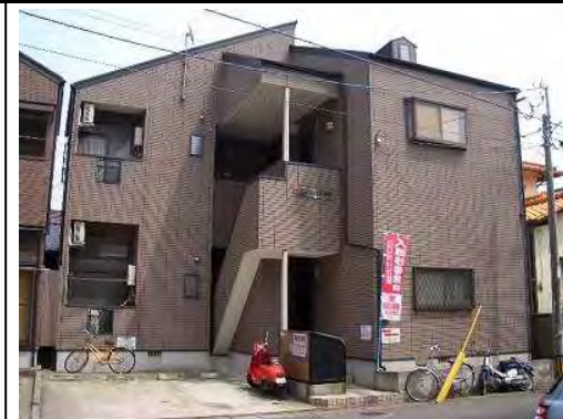
エクシード室見（9月竣工/6戸：福岡市早良区）
