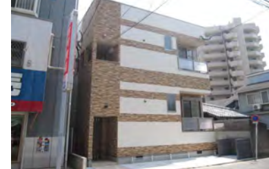
アットイーズ香椎 (5月竣工/6戸：福岡市東区)
