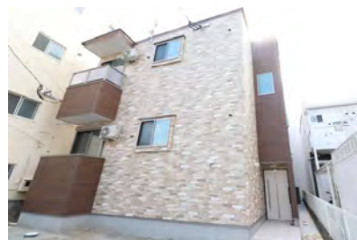
ブラウニー小郡祇園 (4月竣工/6戸：小郡市)
