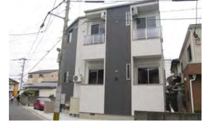
ラフィーネ姪浜 (5月竣工/4戸：福岡市西区)
