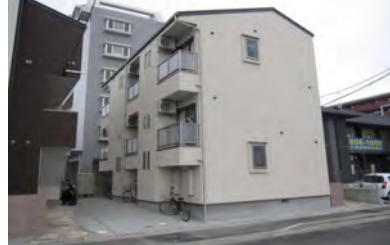
ロザリオカーサVII (4月竣工/6戸：福岡市西区)
