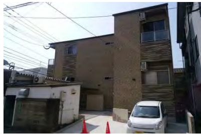
Casa Felice (1月竣工/6戸：福岡市東区)
