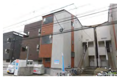
パストラル周船寺 (4月竣工/6戸：福岡市西区)
