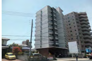
アリュール姪浜 (3月竣工/19戸：福岡市西区)
