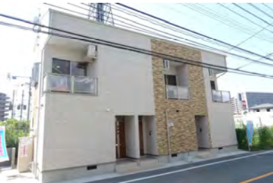
フェリオ千早 (9月竣工/3戸：福岡市東区)
