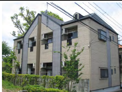
ポラリス筑紫丘Ⅱ (3月竣工/8戸：福岡市南区)
