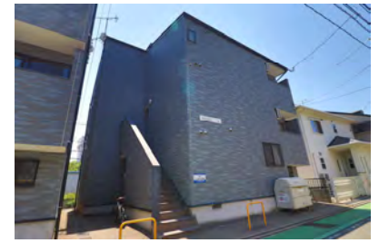
スタイルビュー井尻 (9月竣工/6戸：福岡市南区)
