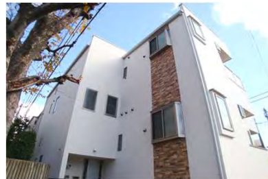
コートドール箱崎 (12月竣工/6戸：福岡市東区)
