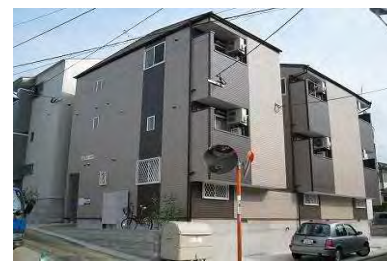
ボーマノワール別府南 (5月竣工/6戸：福岡市城南区)
