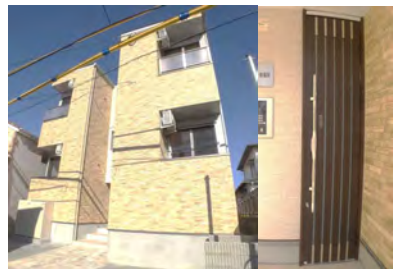
メゾン南福岡 (10月竣工/8戸：福岡市博多区)
