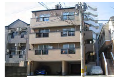
アリエスTAKATORI (9月竣工/13戸：福岡市早良区)
