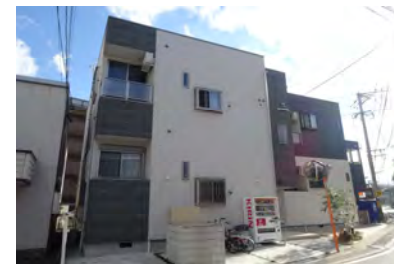
アルル笹原駅東 (3月竣工/6戸：福岡市博多区)
