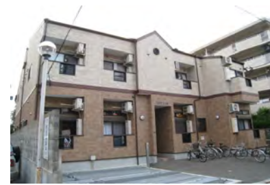
リバティ・JK (6月竣工/16戸：福岡市中央区)
