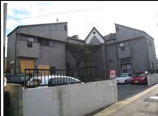
ポラリス山下町（4月竣工/6戸：唐津市）
