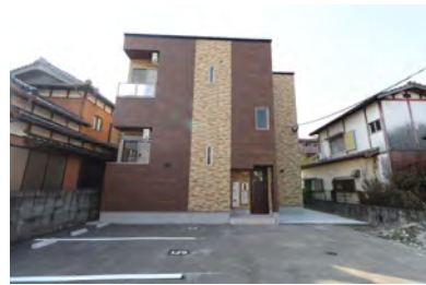
AREA24（3月竣工/6戸：佐賀県神埼市）
