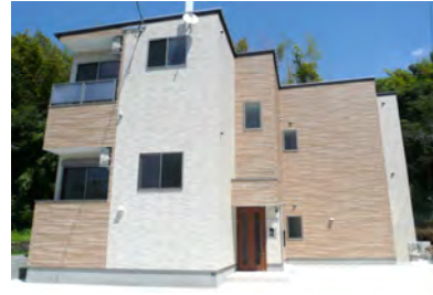
クラリス京町 (9月竣工/6戸：熊本市)
