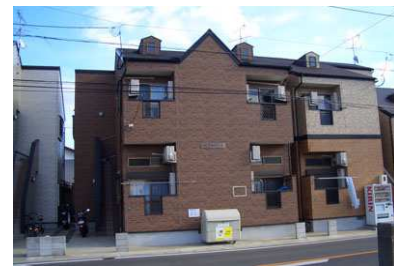
クレールI (11月竣工/8戸：福岡市西区)
