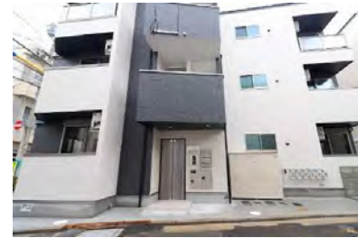
ボマール美野島 (10月竣工/6戸：福岡市博多区)
