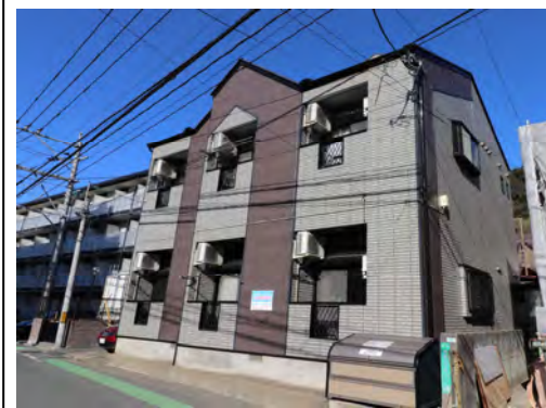
ポラリス愛宕II (12月竣工/6戸: 福岡市西区)
