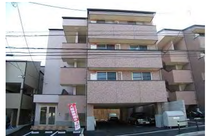
ピュール西の丘（12月竣工/9戸：福岡市西区）
