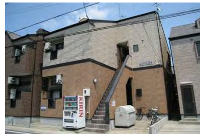
ポラリス壱番館 (11月竣工/6戸：福岡市西区)
