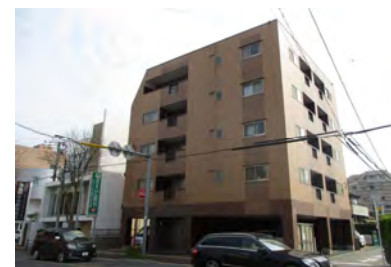
ポラリス梅光園 (9月竣工/12戸：福岡市中央区)
