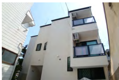
パークメゾン大濠公園 (7月竣工/6戸：福岡市中央区)
