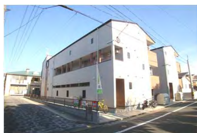
ポラリス光丘Ⅱ (2月竣工/8戸：福岡市博多区)
