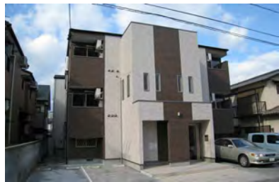
DOME CITY RESIDENCE (1月竣工/16戸：福岡市中央区)
