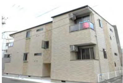
ベラジオ南福岡 (7月竣工/4戸：福岡市博多区)
