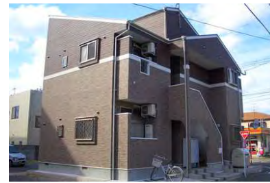
クリスタルK九大南 (12月竣工/6戸：福岡市西区)
