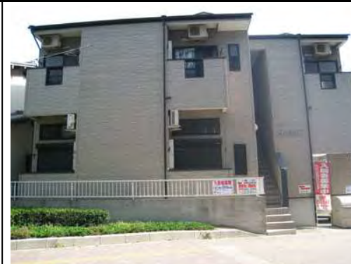
ポラリス姪浜南N (10月竣工/7戸：福岡市西区)
