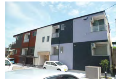
アットイーズ三苦駅前 (6月竣工/8戸：福岡市東区)
