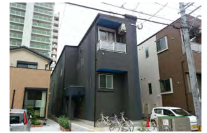
博多イーストブルー (11月竣工/7戸：福岡市博多区)
