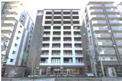
アリエス学研都市II (10月竣工/44戸：福岡市西区)
