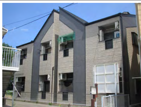
ドリームパレス生の松原 (3月竣工/10戸：福岡市西区)
