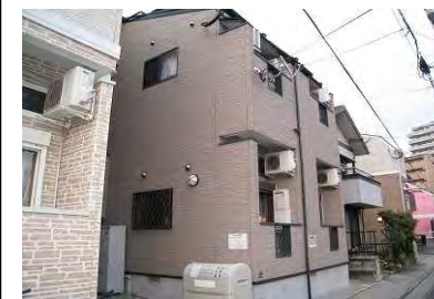
グレースハイツ大橋 (12月竣工/6戸：福岡市南区)
