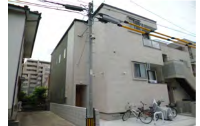
アットイーズ井尻 (4月竣工/4戸：福岡市南区)
