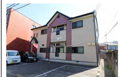
ポラリスNII (12月竣工/4戸：唐津市)
