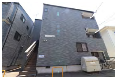
ケイ井尻 (10月竣工/8戸：福岡市南区)
