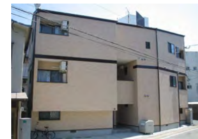
ペガダ室見 (4月竣工/4戸：福岡市早良区)
