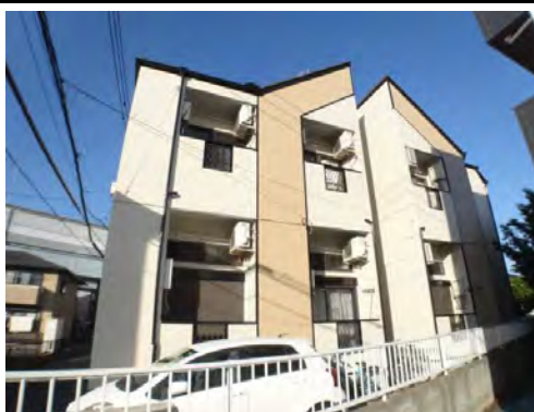
ユートク室見 (7月竣工/8戸: 福岡市西区)
