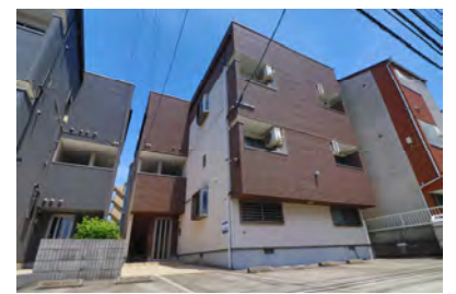
ラフィーネ周船寺 (9月竣工/8戸：福岡市西区)
