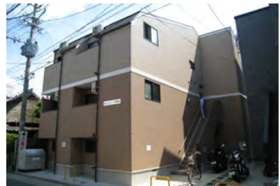
ボラリス井尻駅南 (10月竣工/8戸：福岡市南区)
