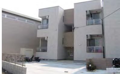
EL POLESTAR II (3月竣工/8戸：福岡市西区)
