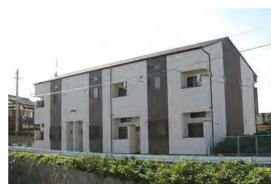
ボルベール姪浜 (11月竣工/6戸：福岡市西区)
